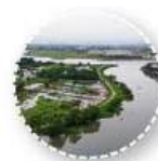
HỆ THỐNG KÊNH NƯỚC
